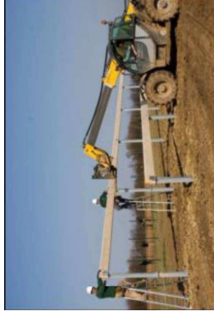
Illustration 20 : Montage des structures souterraines et des modules
