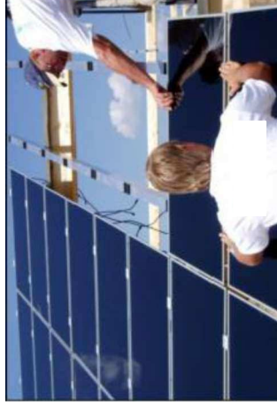
Illustration 20 : Montage des structures souterraines et des modules
